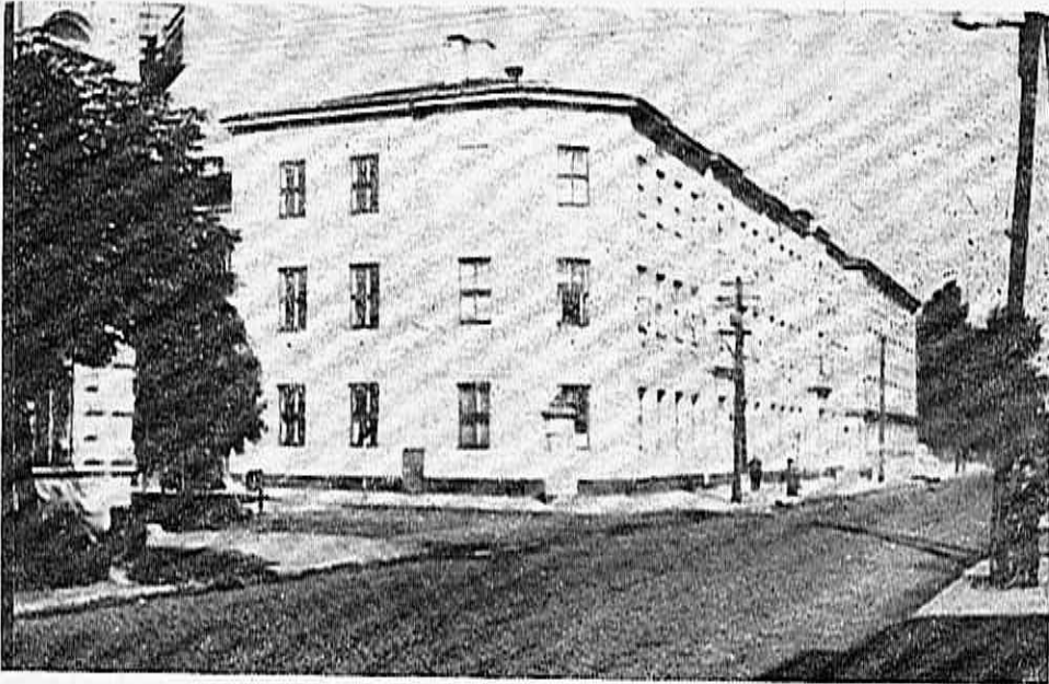
Budynek szkolny i internat Liceum im. Bolesława Prusa w Siedlcach (stan obecny)
